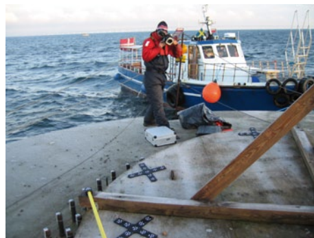
Abb. 10: Messung und Inspektion von 120 Montagebolzen mit dem TRITOP CMM System auf hoher See
