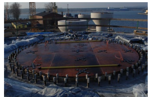
Abb. 9: Anordnung der Montagebolzen im Betonfundament und Messvorbereitung
